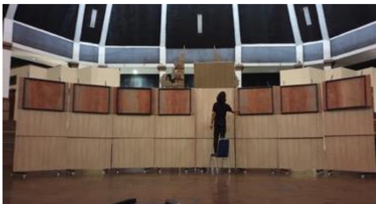
Gambar 8. Penempatan partisi papan reflektor di panggung Candra Metu oleh mahasiswa HMJ Prodi Musik ISI Denpasar.
