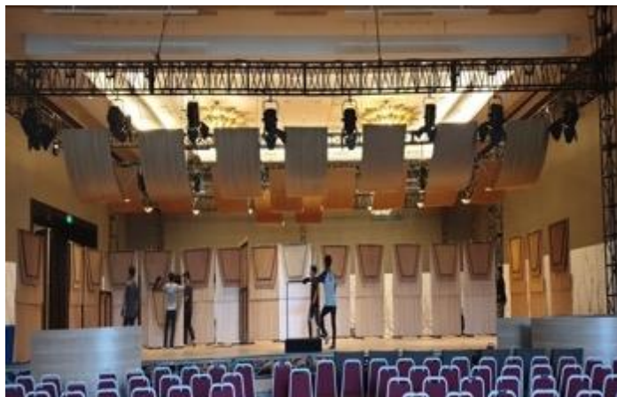
Gambar 6. Proses Pemasangan Papan Reflektor Akustik Portabel Bandung Philharmonic Orchestra .
