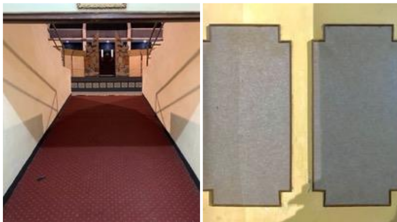
Gambar 4. Permukaan Absorber Material dalam gedung pertunjukan Candra Metu. (Sumber: Grace Alexandra, 2022)
